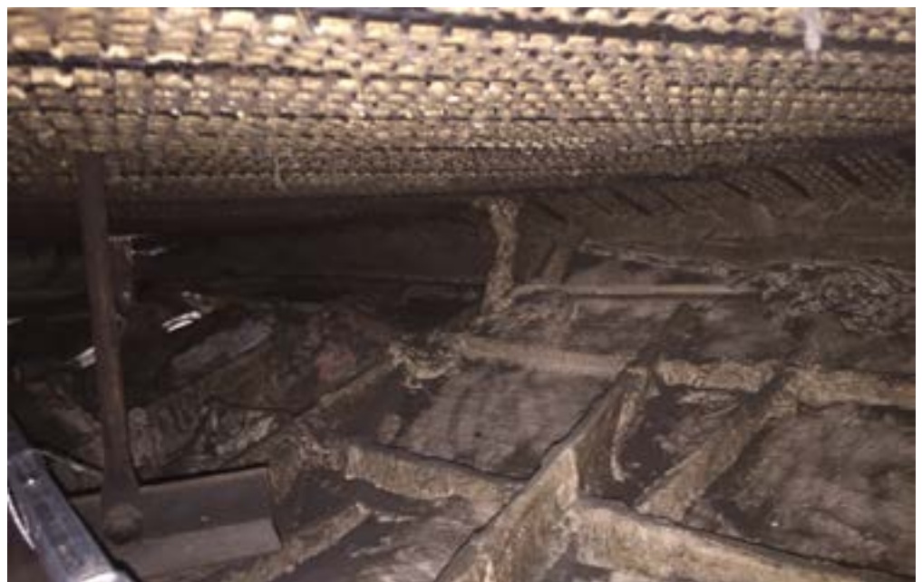
Ffigur 29: Rhan fawr o nenfwd a osodwyd heb gysylltiadau wad digonol i'r paneli. Gallai arolwg amlygu hyn yn hawdd, a gallai gwaith atgyweirio dilynol ddatrys y problem.
