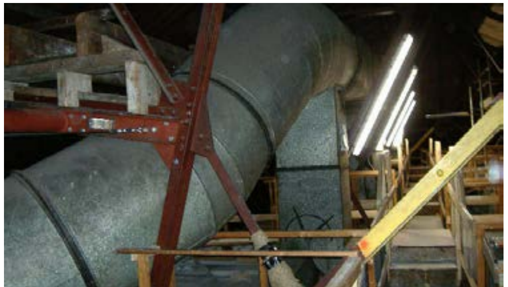
Ffigur 31: Mewn gwagleoedd nenfwd, mae offer mecanyddol mawr a llwybrau cerdded astellog (de isaf) yn cuddio'r nenfwd plastr ffibrog islaw ac yn amharu ar y gwaith archwilio.
