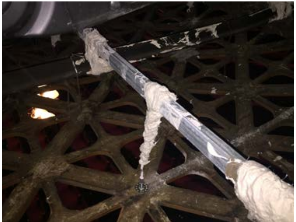
Figure 33: Ffretwaith plastr ffibrog, yn cael cynhaliaeth ategol gan drawst newydd a wadiau wedi'u cryfhau. Dyma ddull safonol o wneud nenfyddau crog yn fwy sefydlog.
